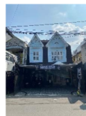
Gambar 4. Façade bangunan Satus Kedai
